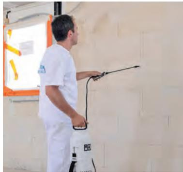
Dans le cas d'un support très absorbant (béton cellulaire), ou par temps très chaud, appliquer le primaire Lutèce® Régulateur de fonds.
