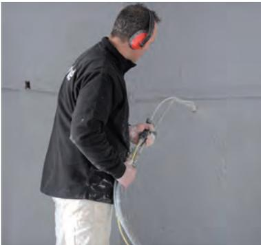
2<sup>e</sup> passe : projection de 2 mm environ sur chaque pan de mur (moins de 30 min après la 1<sup>re</sup> passe).
