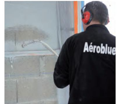
1<sup>re</sup> passe : projection de 3 mm d'épaisseur environ par pan de mur. Laisser 15 à 20 minutes avant la 2<sup>e</sup> passe.
