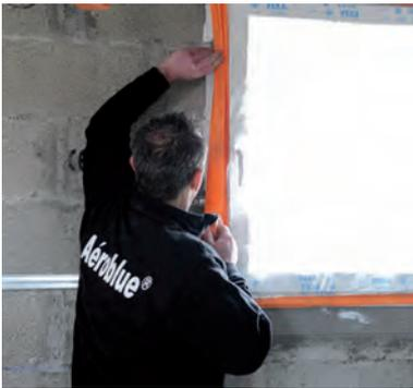
Protection des menuiseries extérieures et des fourrures pour les doublages sur ossature (si déjà posés).
