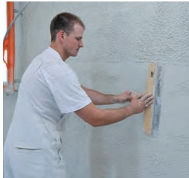
Si solution de doublage sur ossature, aplanir sur une hauteur de 20 cm à l'endroit précis où la fourrure sera posée. Se munir d'un couteau à enduire et d'un laser si possible.
